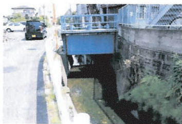
いよいよ水利施設が出てくる
